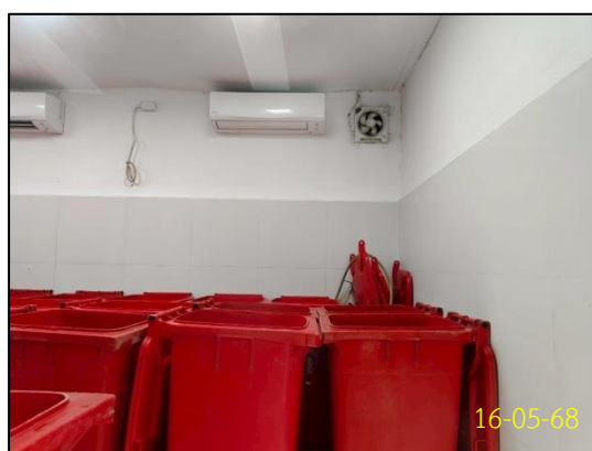
การปรับอุณหภูมิติดตั้งเครื่องปรับอากาศ ในห้องพักมูลฝอยติดเชื้อ
