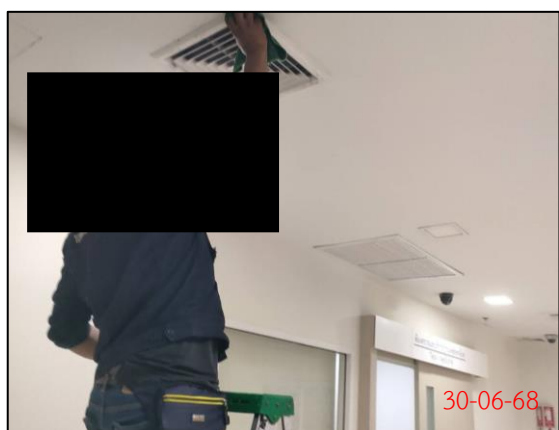
ล้างเครื่องปรับอากาศภายในอาคาร
