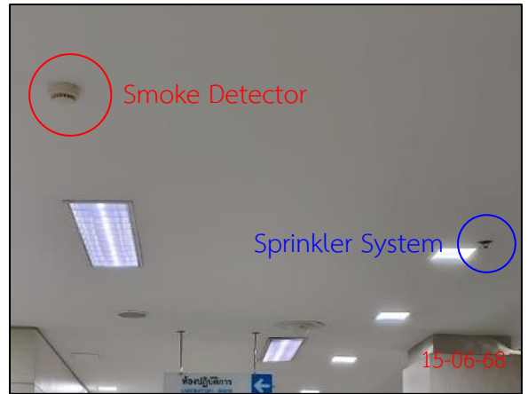
เครื่องตรวจจับควัน และสปริงเกอร์ดับเพลิง
